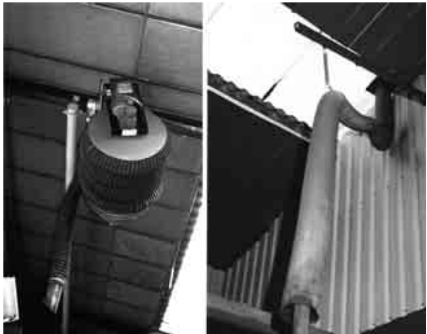
Fig. 8.1 Afzuigstelsel voor uitlaatgassen
